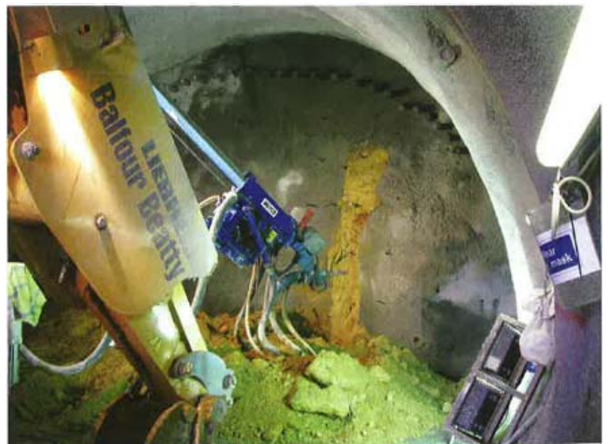
写真-1 掘削機アーム先端からのコンクリート吹付状況
