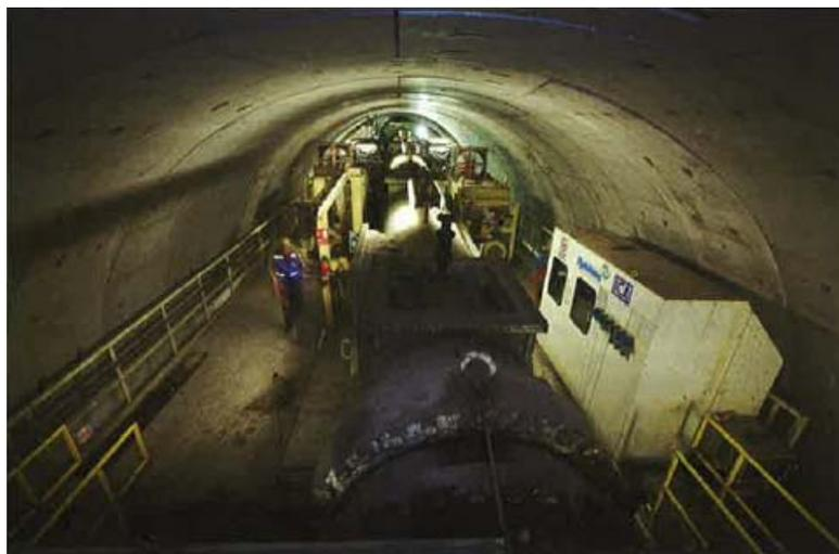
写真-1 メキシコで最大径の直径 10.2m の泥土圧式の TBM
