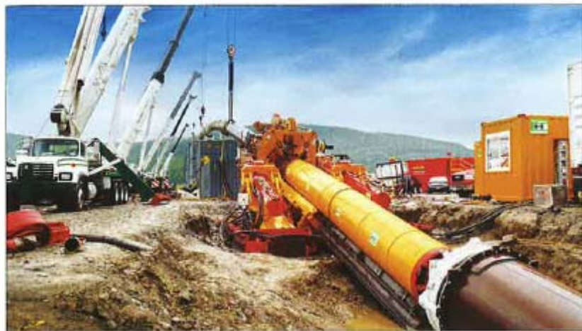
写真-1 地面に固定された押し込み機と、設置された掘進機および 1,067mm のパイプライン
