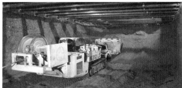
参考写真 掘削状況
