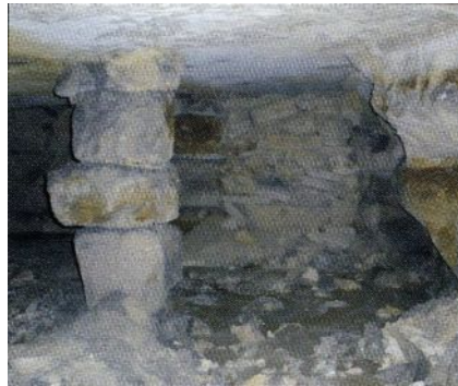
補強前の地下碎石場の状況
