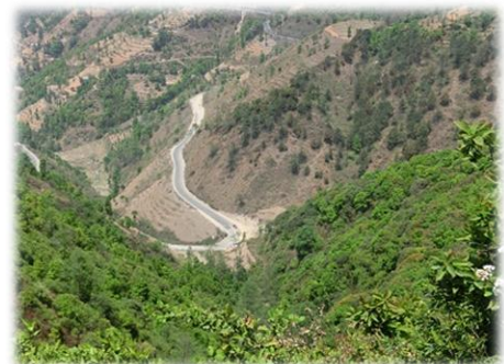
トンネル建設予定地 (ナグドゥンガ峠)
