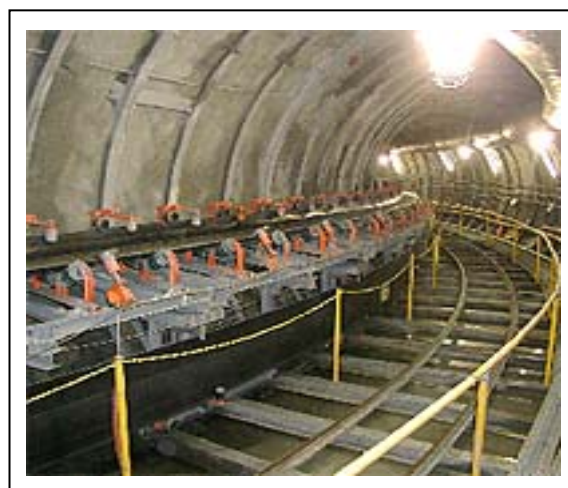
急曲線での設置状況 (壁面左に設置されているのがベルト コンベアシステム)
