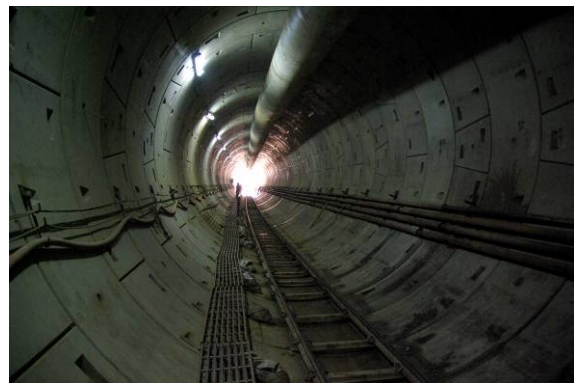
写真-4 シールド坑内
