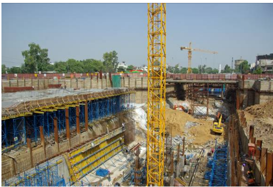
写真-1 MALVIYA NAGAR 駅施工状況
