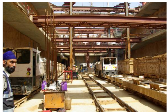
写真-2 HAUZ KHAS 駅施工状況
