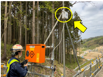
坑口前ヤード
