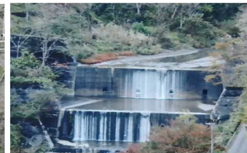
ナンノ谷第1砂防堰堤（600m先）
