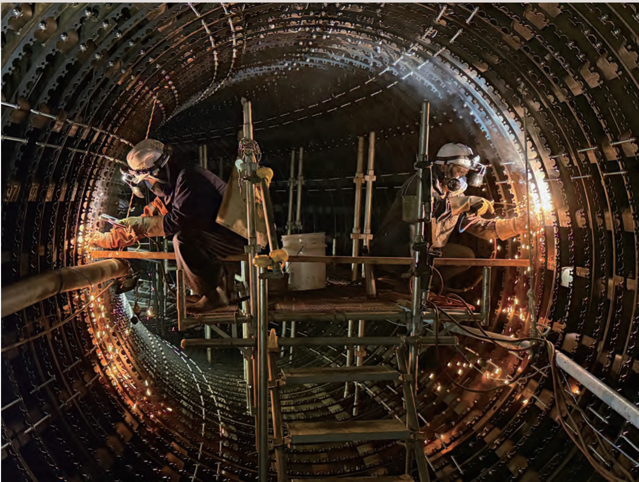
溶接職人 ／松戸市長津川第一号雨水幹線工事 酒井 武人[東京都]
