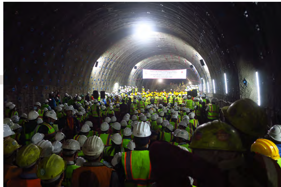
長かった… ／ネパール ナグドゥンガトンネル本坑内貫通地点付近 井上 賢一[神奈川県]
