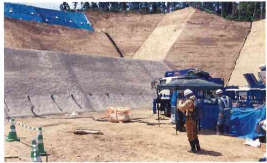
写真-3 試験施工の状況
