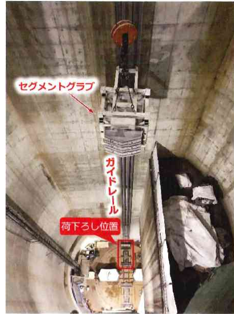
写真-6 セグメントグラブ稼働状況
