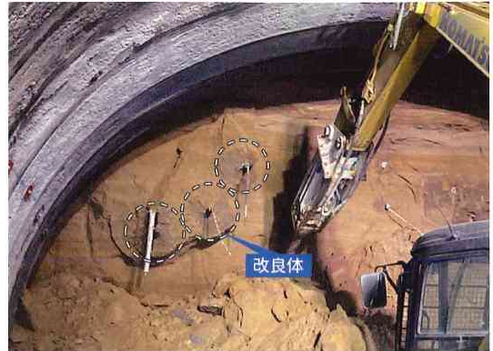
写真-5 鏡補強工の改良体
