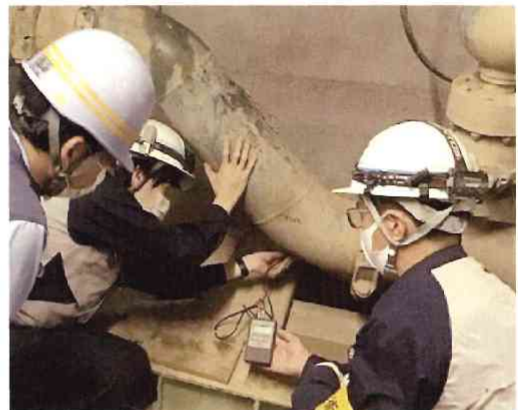
写真-2 排泥配管肉厚計測状況
