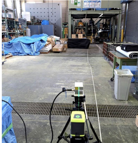
図7 LiDAR 計測を実施した現場の実景写真
