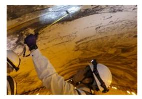
写真-2.3 打音検査作業状況
