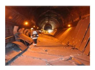
写真-2.1 笹子トンネル天井板落下事故 4)
