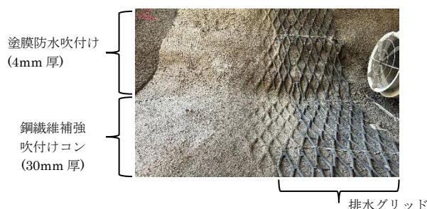
写真 新モンリオール工法の構成部材
