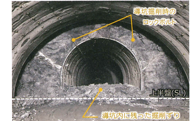
写真-7 本坑切抜け時の切羽写真
