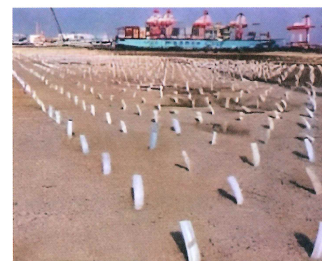
写真-1 PBD埋設状況
