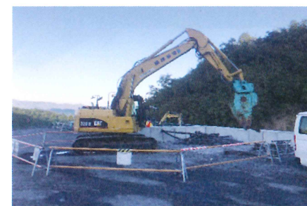
写真-2 油圧圧砕機
