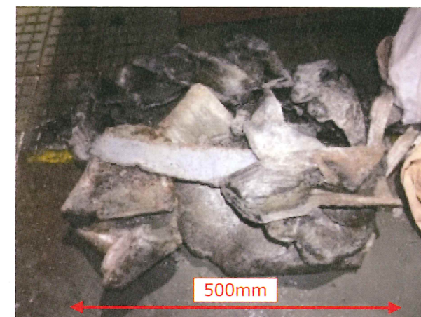
写真-7 鋼管矢板大割れ切削片
